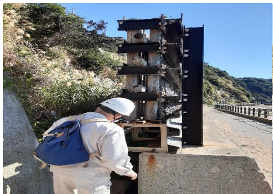
(間伐材を用いた落石防止工)
