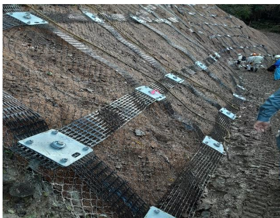
(Geo ベルト工法の施工地)
